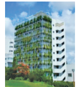
壁面緑化 建築学棟
